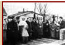
En 1950, en présence de Mgr Kerkhofs et des ministres Buisseret et Rey, a eu lieu la pose de la première pierre de la Chapelle-Mémorial Walthère Dewé.
